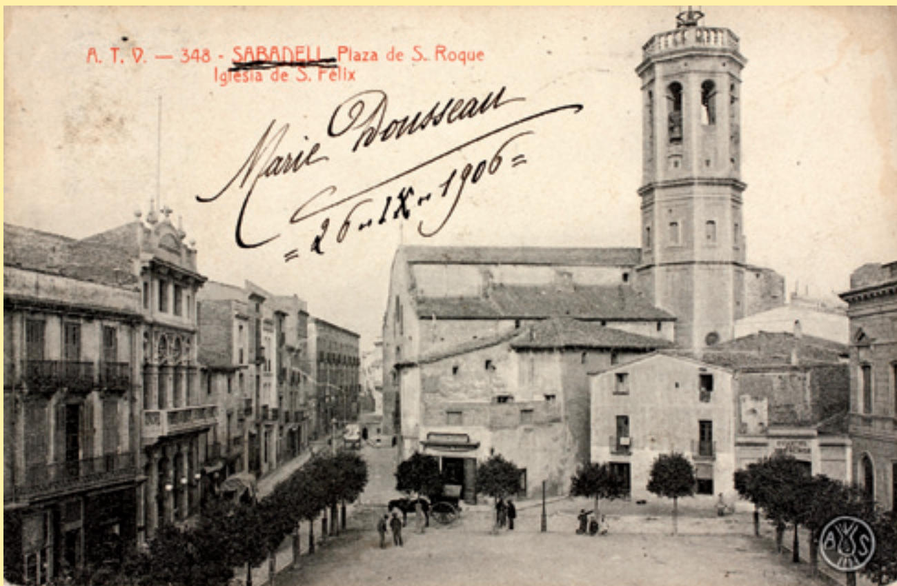
Fotografia 1. L'església de Sant Fèlix amb la nau principal gòtica i les ampliacions barroques del segle XVII encara dempeus, i el campanar del segle XVIII. S'observen les edificacions que s'havien anat construint al llarg dels segles al davant de la façana sud i a la part del darrera, a tocar del campanar, com també l'inici del carrer de l'Església. Sabadell, 1906. Edició postal (Àngel Todrà Viazo / AHS).
